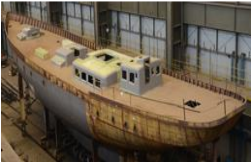
Goleta Escuela “Santa María de los Buenos Aires”. (en construcción en el Astillero TANDANOR).
