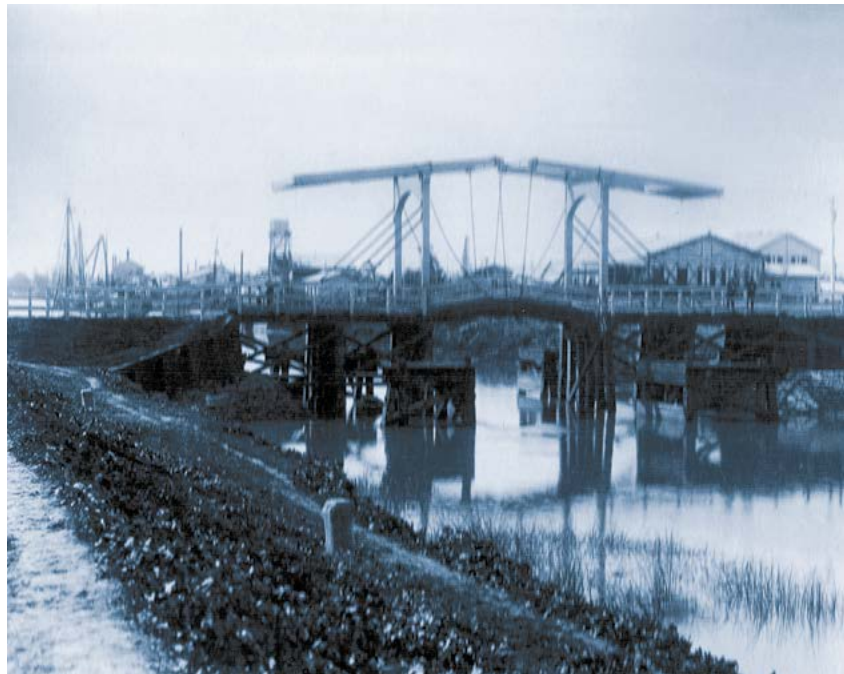
Puente levadizo doble en Canal Oeste de Puerto La Plata. Proyecto de Jan Abel Adrián Waldorp. Foto: Bradley (1888), en el Archivo y Museo Dardo Rocha, Municipalidad de La Plata
