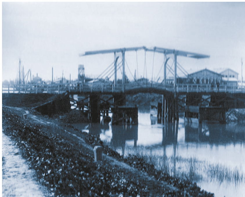
Puente levadizo doble en Canal Oeste de Puerto La Plata. Proyecto de Jan Abel Adrián Waldorp. Foto: Bradley (1888), en el Archivo y Museo Dardo Rocha, Municipalidad de La Plata
