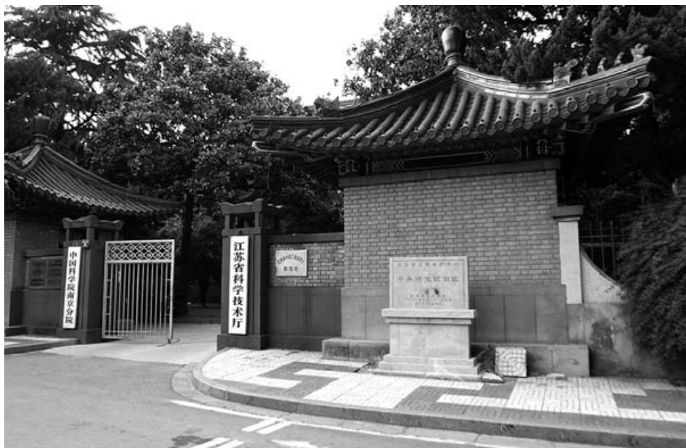
Edificio de la Academia China de las Ciencias
