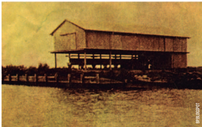
Muelles, depósitos y caballerizas de posta
