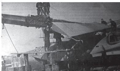
Reparación de un ala de un Catalina.
