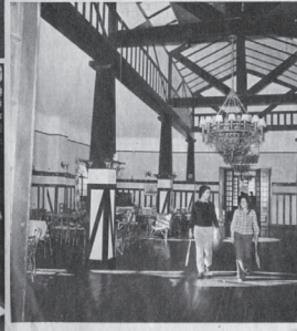
Embarcadero sobre el río Luquán, frente del edificio que se levanta en la calle Victoria 284, e interior de las instalaciones que la institución posee en la filial Tigre.
