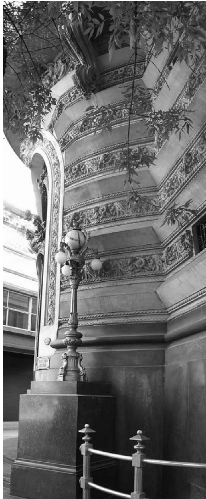
Parte del zócalo y adornos del frente de la planta baja.
