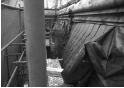
Tareas de restauración en la mansarda.
