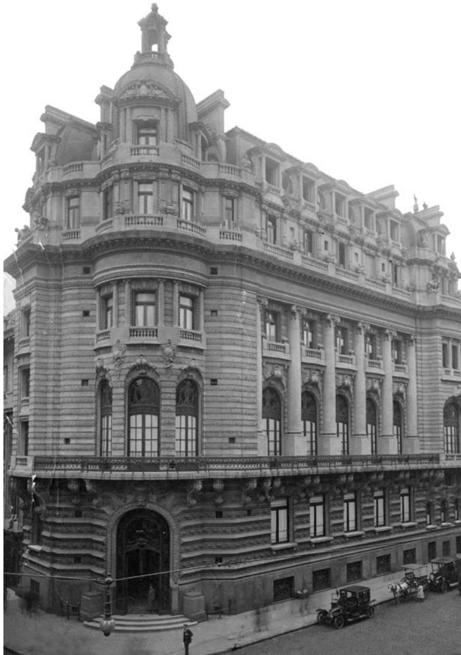
El edificio, recientemente inaugurado. Fuente: Archivo General de la Nación Dpto. Doc. Fotográficos. Buenos Aires. Argentina.
