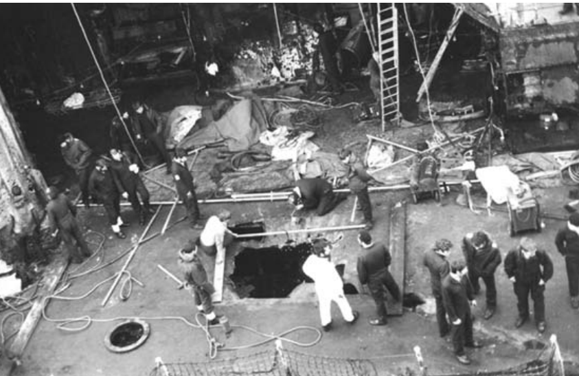
Destrucción del hangar, helicóptero y boquete en cubierta hangar del HMS Glamorgan .
