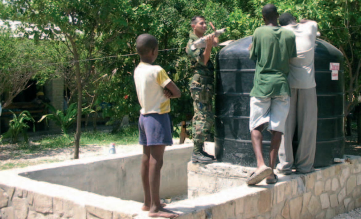
Reparación de instalaciones en un orfanato en las afueras de Gonaïves.
