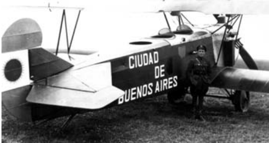
Zanni junto al avión para la primera etapa (terrestre), nótese la modificación de la tercera cabina y los radiadores de aceite a los costados del motor. Foto: A.G.N.
