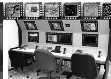
Sala de Comando y Control.
