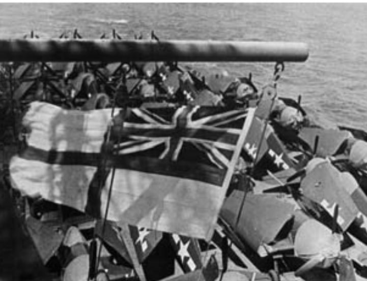
El CVE HMS *Rajah*, empleado como ferry para el transporte de aviones, con una carga de 82 F6F-5 Hellcat desde San Diego a Guam.
