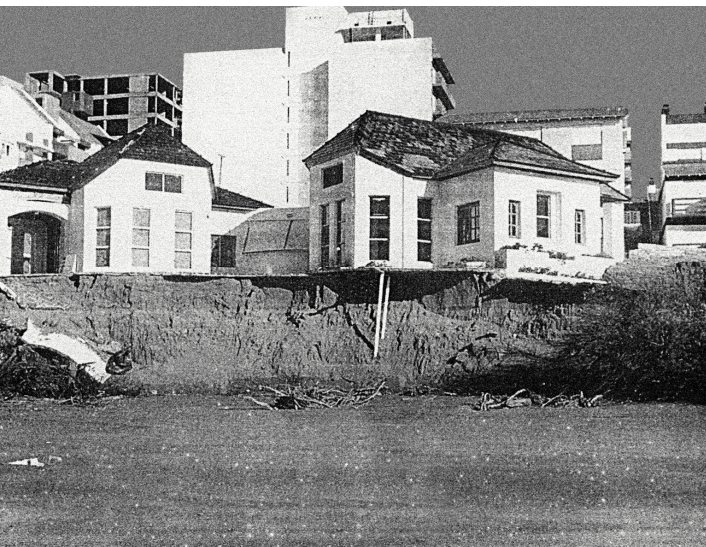
Manejo costero. Décadas de descuido y falta de previsión interrumpieron el ciclo natural que regula el movimiento de la arena.
