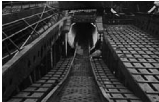
Tubo para estiba de los flotadores de los aviones en el I-400 (a estribor del hangar).
