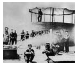
Torre del Monitor .
