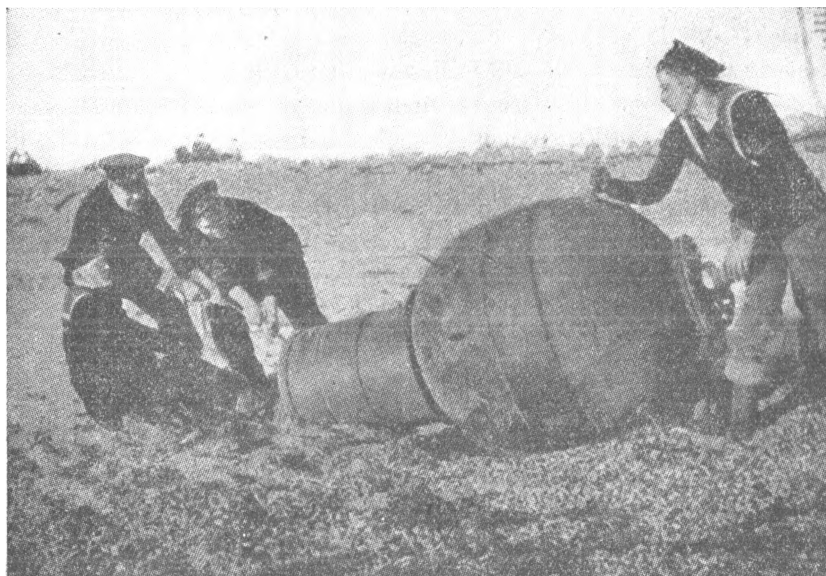
Sacado el mecanismo de fuego, la dotación procede a extraer la carga interna
