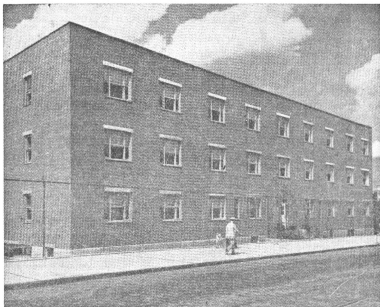
FIG. 1. — Edificio de la Clínica Dental - Arsenal de la Marina, Nueva York
