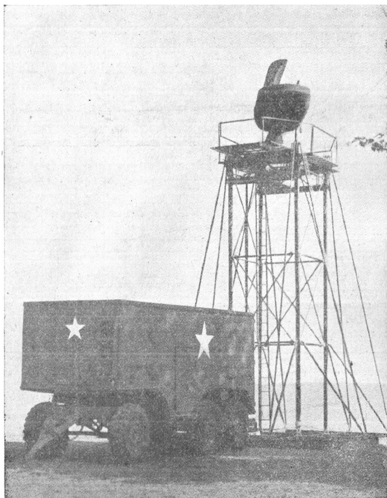
FIG. 8. — Camión, torre y radiador del AN/MGP-1. El radiador en forma de "Bath-tub", es elevado por la torre para alcanzar su posición de funcionamiento
