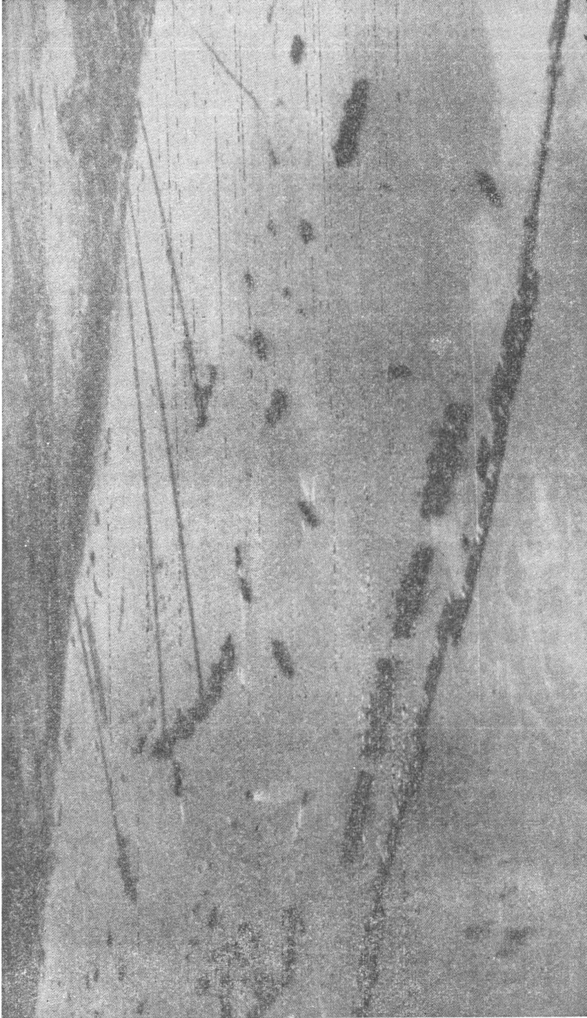
Vista general, a vuelo de pájaro, de uno de los puertos fabricados en Gran Bretaña, para facilitar el desembarco aliado, en la costa de Normandía. Fué remolcado por secciones hasta frente a Arromanches, donde se instaló
