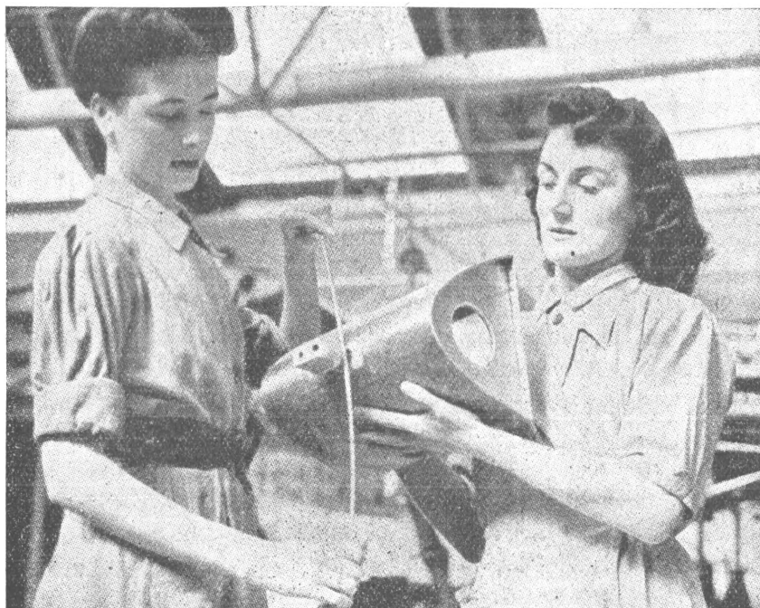
Aparato que llevan los aviones británicos para poder cortar los cables de los globos afectados a la defensa antiaérea
