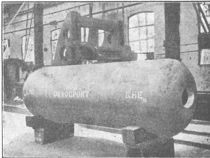
Remachado hidráulico de extremos de colector
